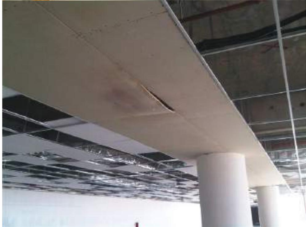
Se observa cómo la humedad y el agua afectaron a la placa, causándole deformaciones y desprendimiento por haberse instalado con obra abierta.
