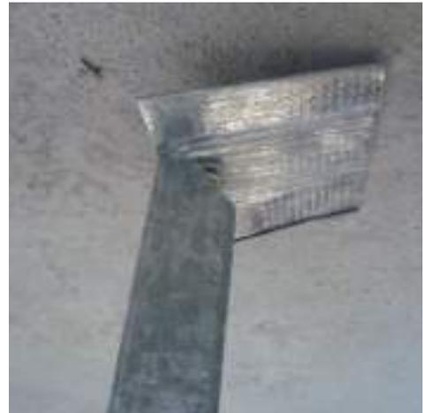
**VELA RÍGIDA EN FORMA DE “T” CON UNA FIJACIÓN LATERAL Y VÍNCULO DE ESTRUCTURA CON TORNILLOS T2**
