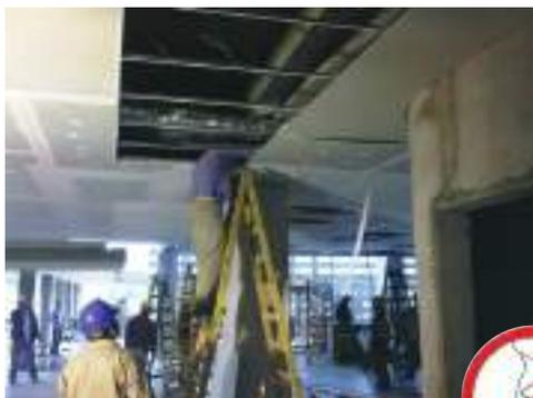
En la imagen se observa cómo se deterioró un cielorraso Junta tomada Durlock® tras ser transitado por un instalador. Insistimos en que hay que tener mucho cuidado, ya que las lesiones por una caída en altura pueden ser muy graves.
