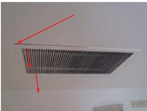
EN LA FOTO SE MUESTRA CÓMO CON EL PASO DEL TIEMPO UNA REJILLA DE AIRE ACONDICIONADO FUE CEDIENDO, ESTO DEBIDO A LA FALTA DE LA PERFILERÍA MENCIONADA.
